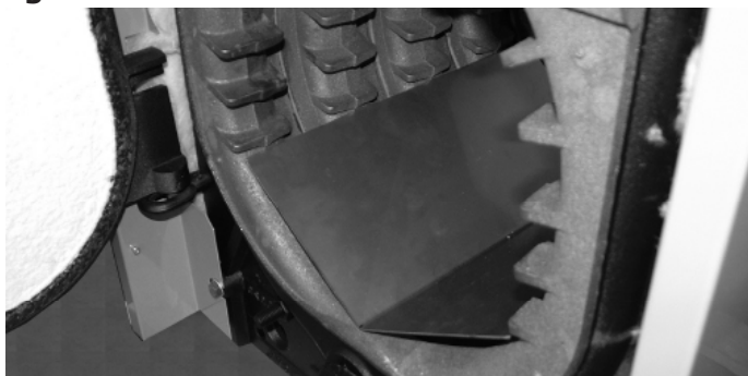
Figure 13 - Déflecteurs de 3 e passage
